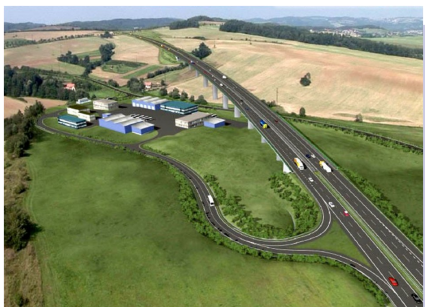
Středisko správy a údržby a služební sjezd u Netvořic
